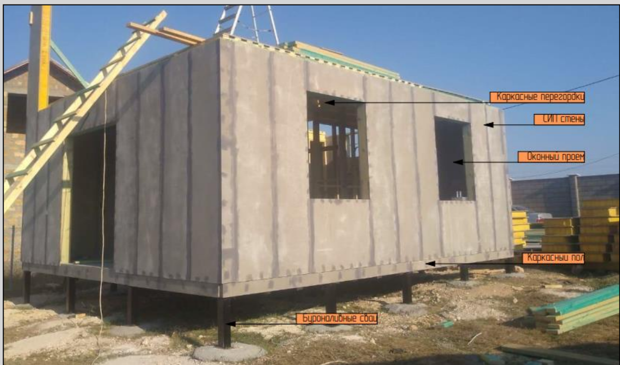
Рис. 3. Стены 1го этажа в сборе
