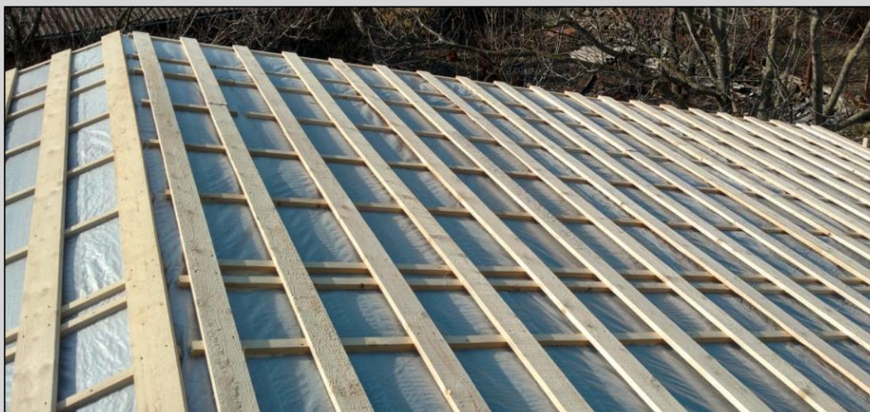
Рис. 12 Ветро-гидрозащита и обрешетка кровли
