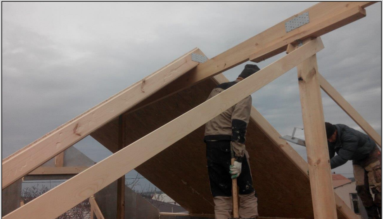
Рис. 15 Узел конькового стыка кровельных панелей с применением конькового бруса и поперечных прогонов
