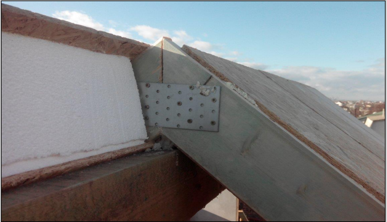
Рис. 14 Узел конькового стыка кровельных панелей
