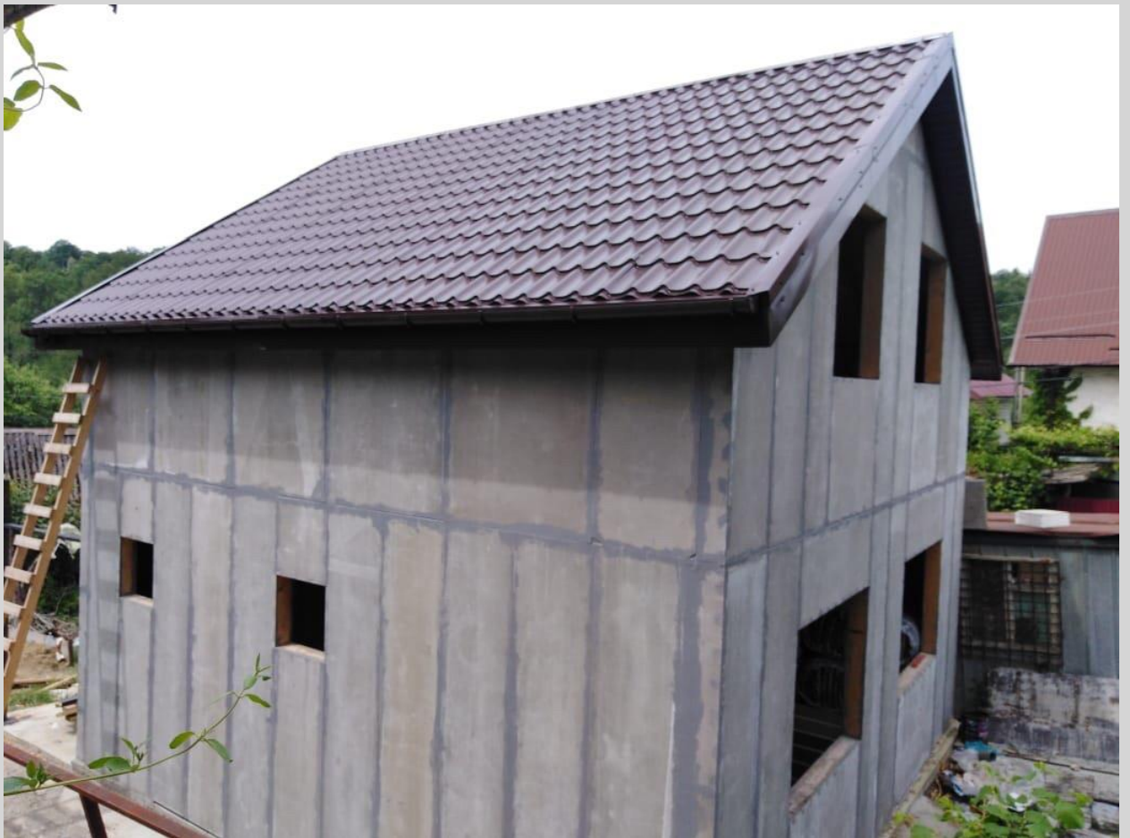
Рис. 17 Кровля с покрытием металлочерепицы
