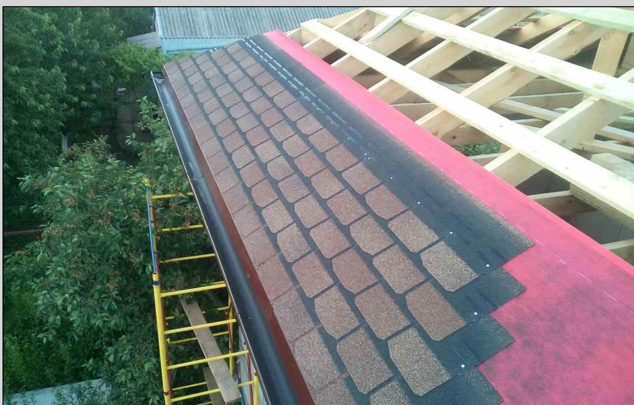
Рис. 13 Подкладочный ковер и гибкая черепица Шинглас
