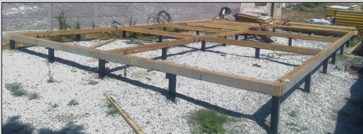
Рис.1 Ростверк в сборе
