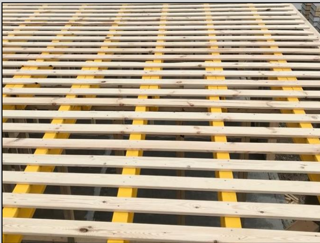
Рис. 7 Монтаж верхней обрешетки
