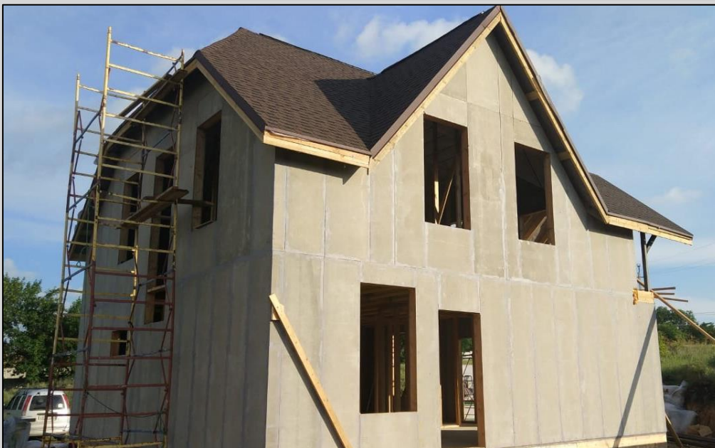
Рис. 16 Кровля с покрытием гибкой черепицы Шинглас
