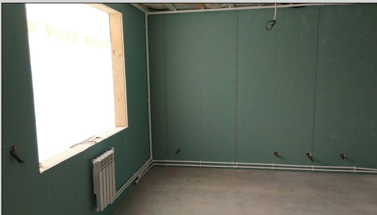
Рис.5 Перегородки с прокладкой коммуникаций
