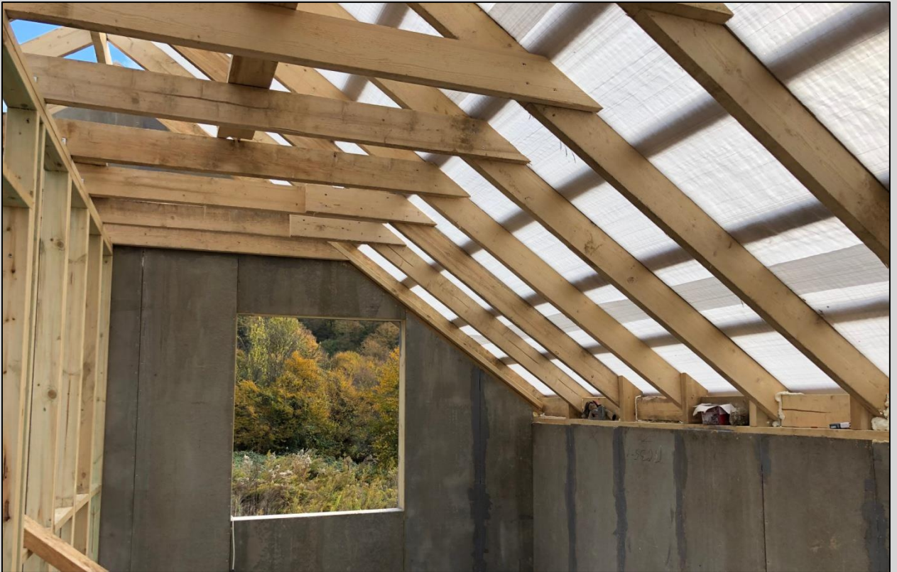
Рис. 11. Стропильная система мансардного типа
