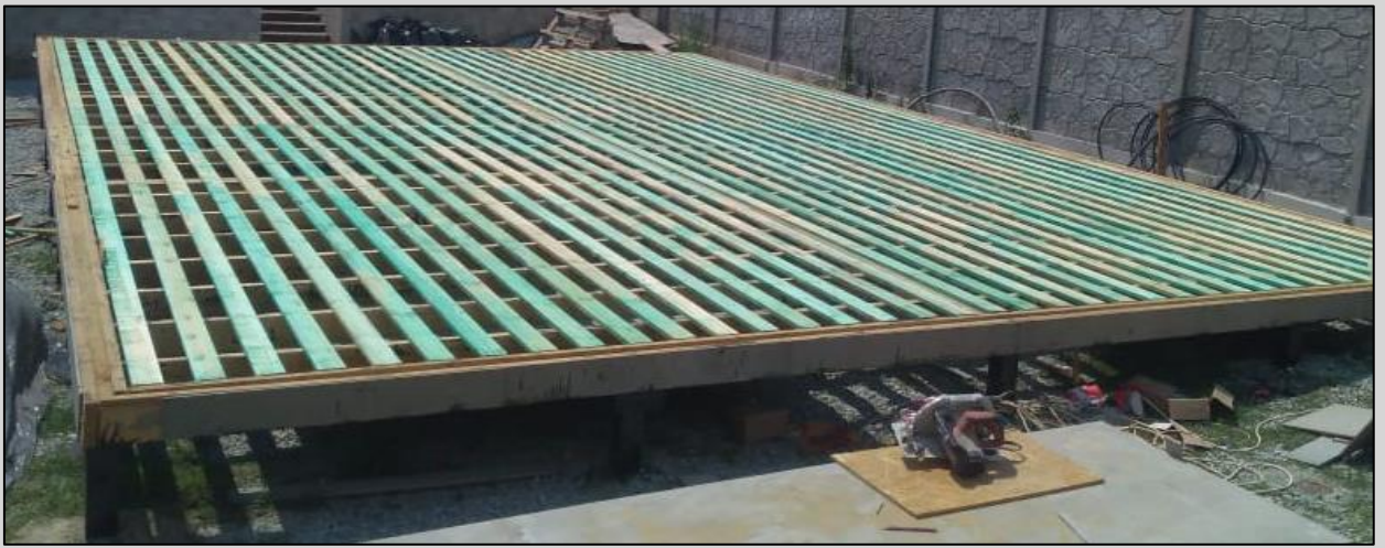
Рис.2 Пол цокольного перекрытия в сборе (без утепления и финишного сплошного покрытия ЦСП)
