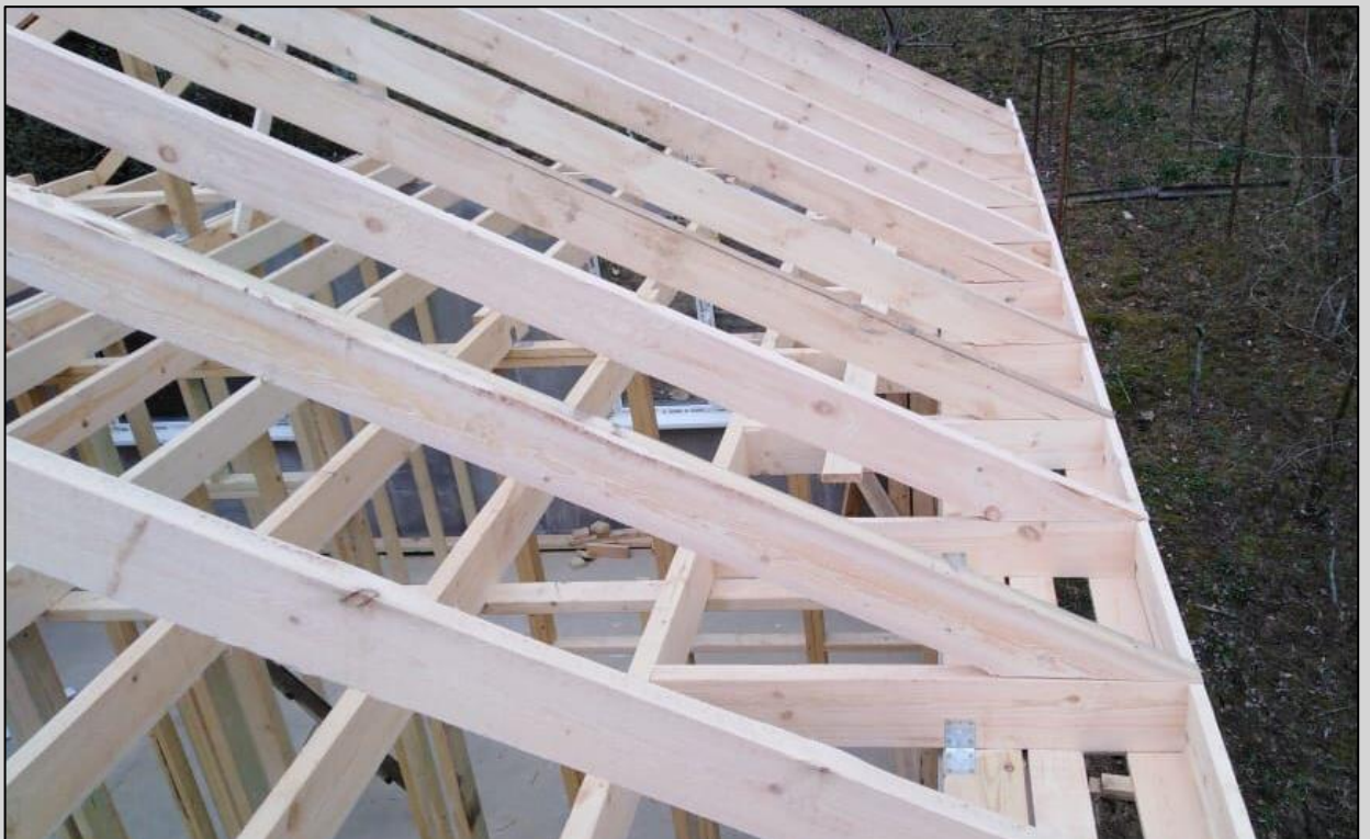
Рис 10. Чердачное перекрытие и стропильная система
